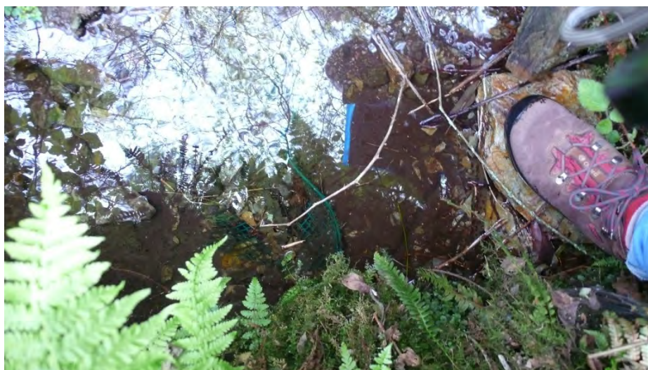
Toma de captación en Regueiro da Fame
