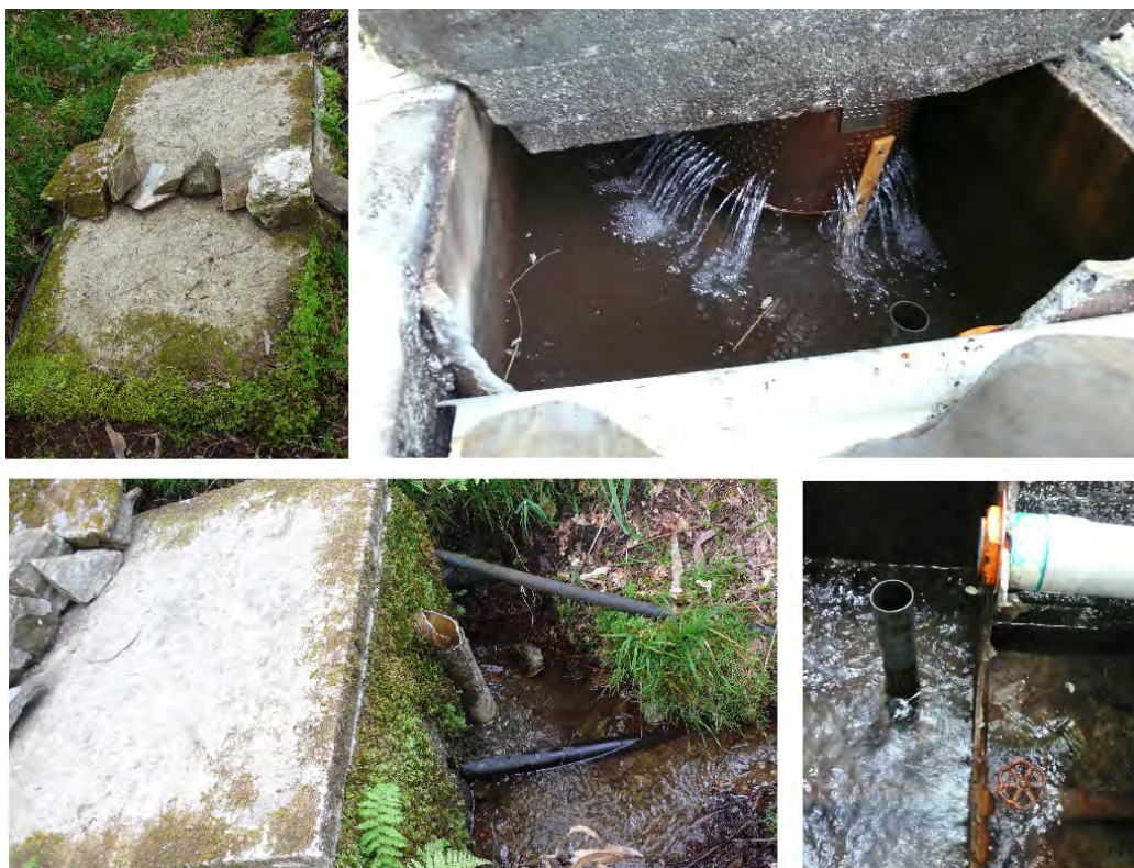
Vista exterior e interior de la caja de captación
