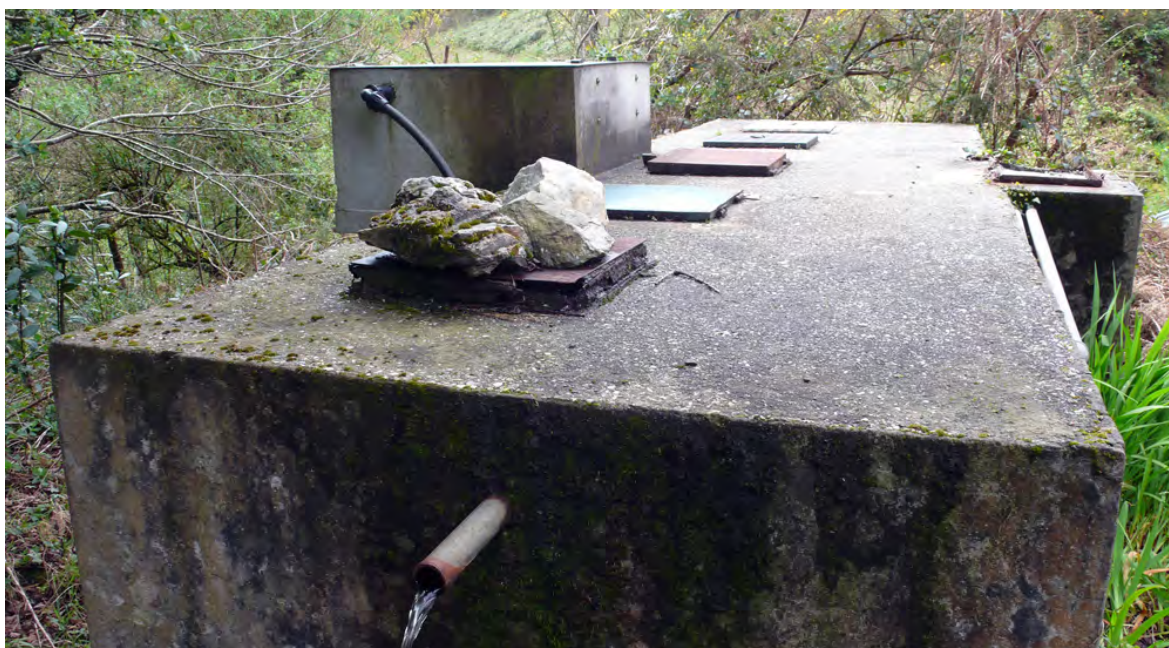
Vista general del depósito
