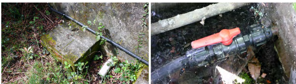
Arquetas posteriores (vista exterior e interior)
